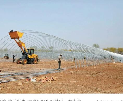
春为岁首，农为行先，广袤田野生机勃发。在南陈镇现代设施农业示范园区的大棚施工现场，工人们正在紧张焊接钢管、打桩立柱、安装拱管，现场繁忙景象。为了不误春种，师傅们加班加点，紧张
