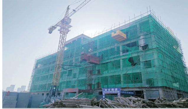
10月30日，庆丰小吃城项目施工现场，工人们正在加紧进行隔墙砌筑、搭建模板等工作，呈现出一派繁忙景象。 令盼 实习生耀博
