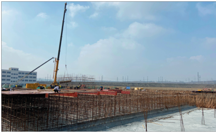
三期工程将于明年3月开工，10月投入使用。建成后将成为亚洲最大的不锈钢全容罐，储气能力可达1亿立方米，将为全市冬季采暖提供供气源，直供潞州、潞城、上党、屯留、长子、壶关、襄垣等7个县区。
