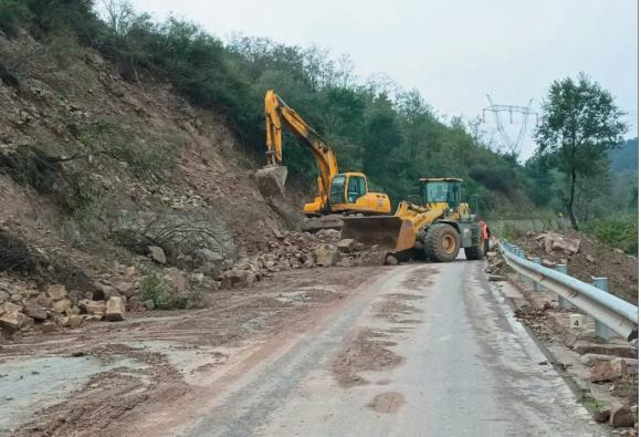
据悉,本次损毁路段主要分布在石哲、南陈、碾张、常张等西部山区乡镇,集中在高填方、临水、临崖、急弯陡坡和过路涵洞等路段,二次损毁突出,泥浆深、水流不断,施工场地环境受限,施工难度很大。
