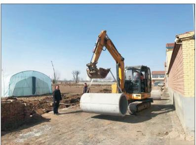
目前已完成了2000米的铺设，排水主管道围绕整个村庄铺设，工程由村东向村西、村北向村南两条线路同时开工，预计5月1日前可完工。管道的修建，将切实保障东堡村内生活排水、村外农田灌溉和涝水排水的畅通，彻底解决农排水梗阻问题，全面提高东堡村农田水利工程防洪除涝抗旱能力，为推动乡村振兴提供坚实保障。
